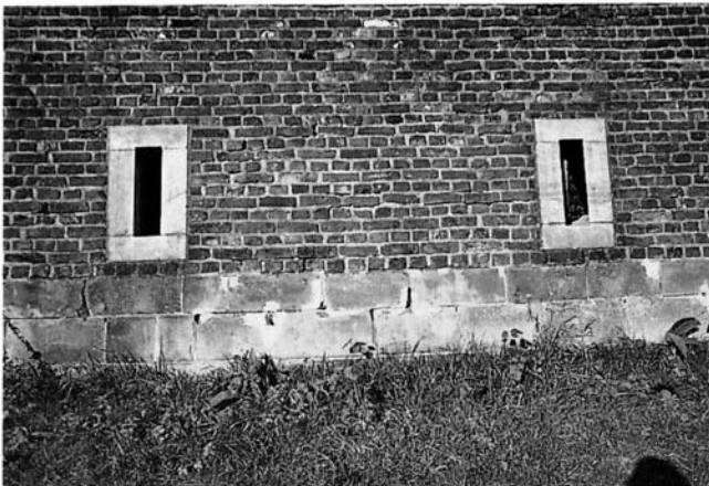
FIGUUR 12. Om t  rigoreus gerestaureerde muren uit de periode 1977-1982 (zie figuur 1) voor de Muurhagedis weer enigszins geschikt te maken werden holletjes, open voegen, winterholen en zonnepaneeltjes gecre erd (foto: B. Kruytenjens).
