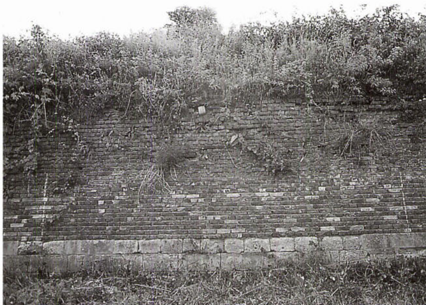
FIGUUR 8a. Muur vóór de restauratie (foto: B. Kruyntjens).
