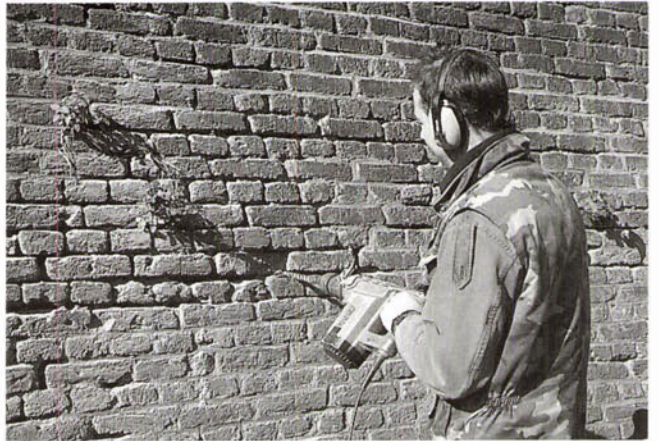
FIGUUR 6. Voegen werden hier en daar open gelaten en er werden holletjes geboord. Door deze voorzieningen her en der over geconsoli- deerd muurwerk te verdelen zijn stepping- stones gecreëerd (foto: B. Kruyjtjens).
