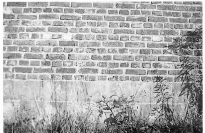
FIGUUR 1. Slecht voorbeeld van restauratie uit 1977: alle holletjes, richeltjes, uitstekende stenen en muurvegetaties zijn weggerestaureerd met keiharde Portlandcement. In de mergelplint zijn nergens meer holletjes of zonneplateautjes aanwezig (foto: B. Kruyntjens).
