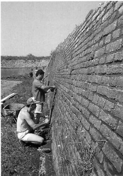
FIGUUR 5. Met satéstokjes is aangegeven welke halletjes bij het voegen open gelaten moesten worden (foto: B. Kruyntjens).
