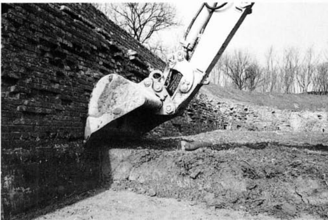
FIGUUR 13. Door het uitgraven van de mergelplinten zijn er weer vele m2 muur beschikbaar geworden voor de Muurhagedis (foto: B. Kruytenjens).
