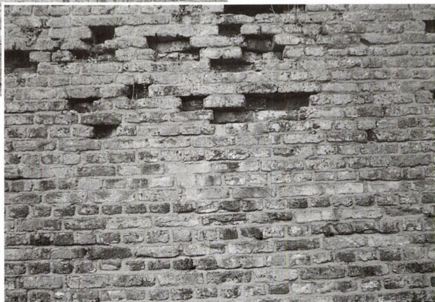
FIGUUR 8c. Detail van figuur 8b. Door ontbrekende bakstenen niet door nieuwe te vervangen zijn er groeiplaatsen voor muurplanten en zonnebankjes voor Muurhagedissen behouden gebleven (foto: B. Kruyntjens).
