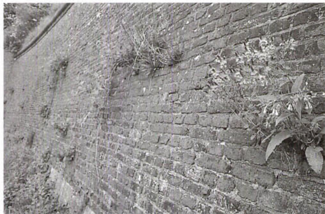
FIGUUR 2. Beter voorbeeld van restauratie uit 1979: in de mergelplint werden diverse oude mergelblokken gehandhaafd waardoor een deel van de oude winterholen gespaard werd. In het bakstenen deel werden hier en daar voegen open gelaten en planten gespaard (foto: B. Kruyntjens).
